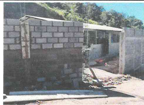
Foto 4: Se observa el avance de la pared a un 80% quedando pendiente la sustitución de la talanquera por un portón.
