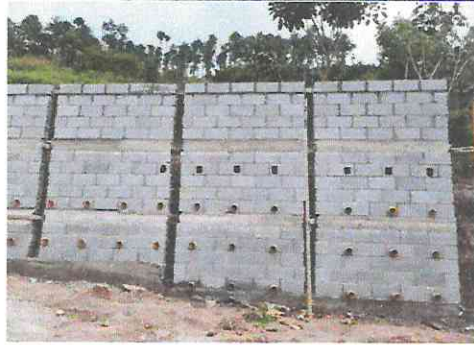
Foto 3: se evidencia nuevamente que en esta parte ya fue realizada la fundición y construida a un 90% la pared del muro.
