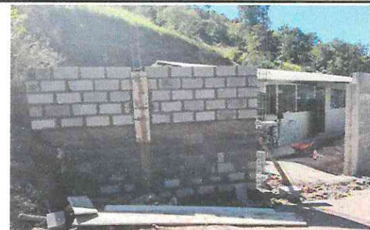
Foto 6: se evidencia la sustitución de la malla por muro de block a un 80% reflejando el cierre total de agujeros e ingresos no permitidos.
