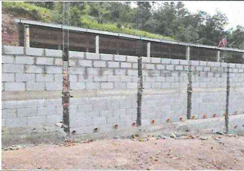
Foto 1: Se observa que en la parte de enfrente cerca de los sanitarios ya fue fundido el cimient y construido un 80% de la pared.
