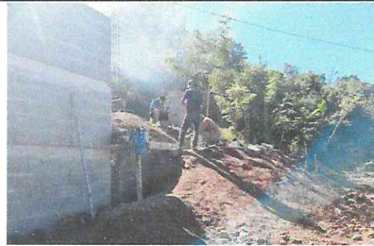
Foto 2: Esta parte es la que limita el terreno del establecimiento con el del vecino, se puede observar que la fundición ya fue realizada y la construcción de la pared esta a un 30%
